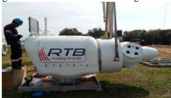
Figura 2: Comissionamento de Aerogeradores
